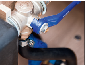
Suoraviemäri – jätevesisäiliön ohitus (ei Safir 600 TDL)
