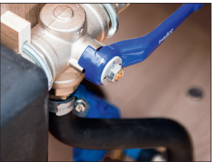
Direktavlopp – förbikoppling gråvattentank (ej Royal 600 TDL, standard Imperial)
