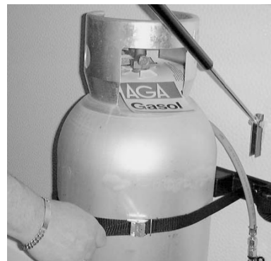
Kontroller at gassflasken er ordentlig festet.
