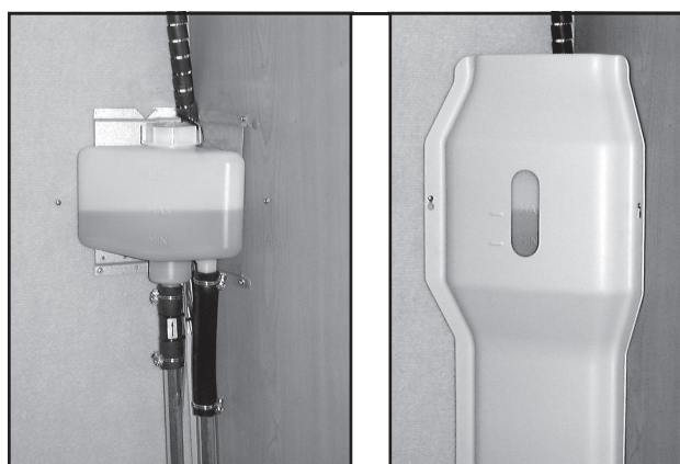
Paisuntasäiliö ja peitelevy tarkastusaukkoineen.
