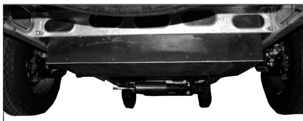
Gråvattentanken är monterad vid husbilens bakaxel.
